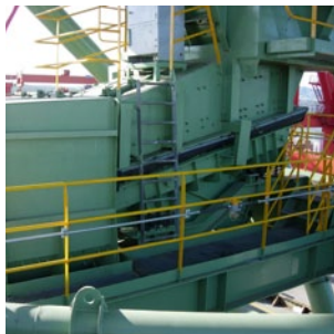
Hafenumschlag Terminal operation
